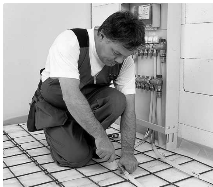
Gulvarmerør fastgøres til armeringsjern
